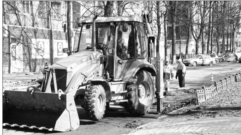
Ремонтные работы на проспекте Ленина.
