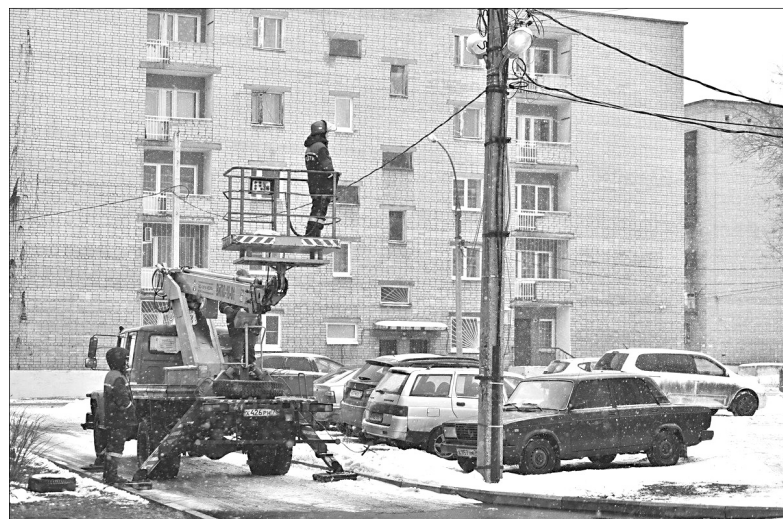
Замена приборов освещения. Республиканский проезд.
