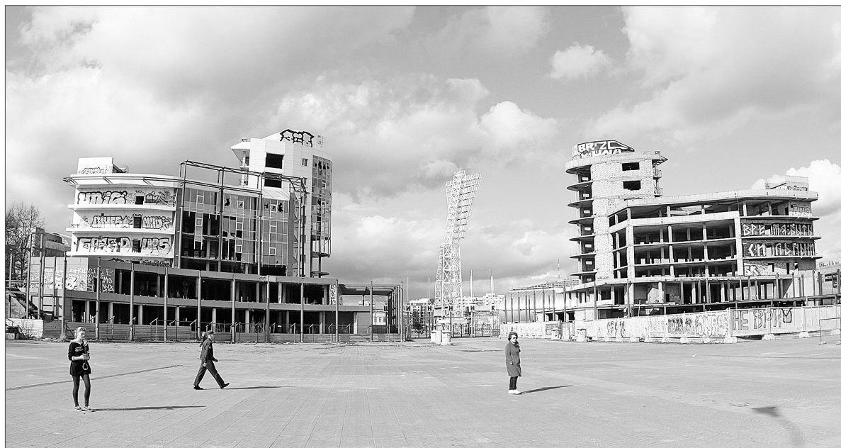
Недострои на площади Труда.
