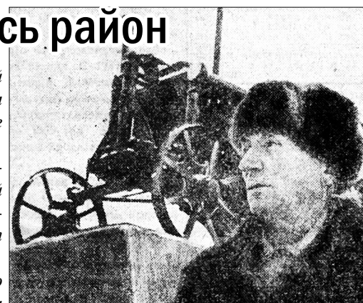
В.И. Смелов возле своего трактора, установленного на пьедестале.
