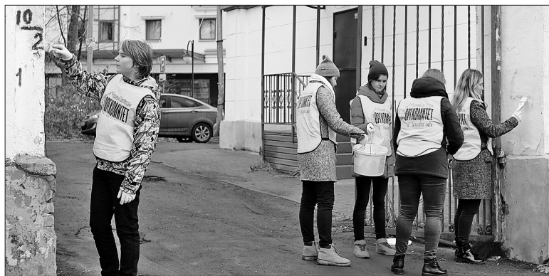
Идет покраска столбов ограждения на Волжской набережной.
