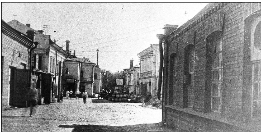
Заводская территория. 20-е годы.
