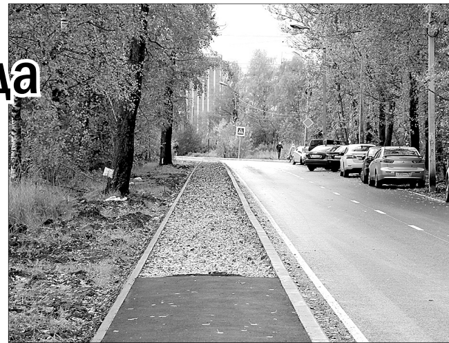
На улице 29-я линия заменен верхний слой асфальта, установлен бордюрный камень.
