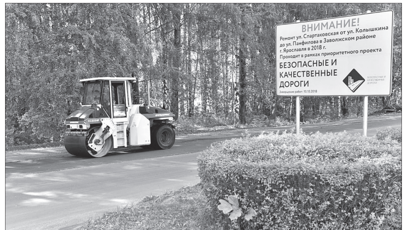
На Спартаковской завершается укладка выравнивающего слоя.
