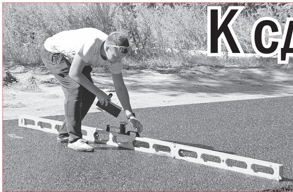
На улице Шоссейной специальной рейкой с уровнем замеряется уклон.
