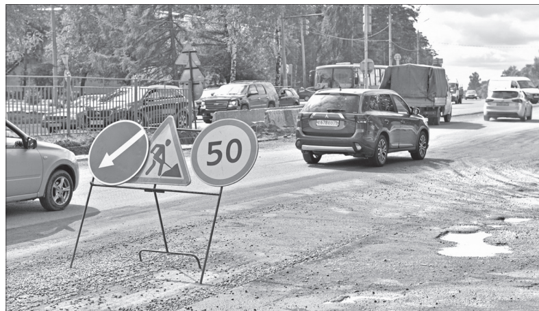
На проспекте Авиаторов работу придется переделать.
