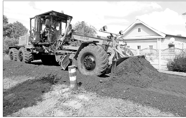
Ремонт улицы Льва Толстого.
