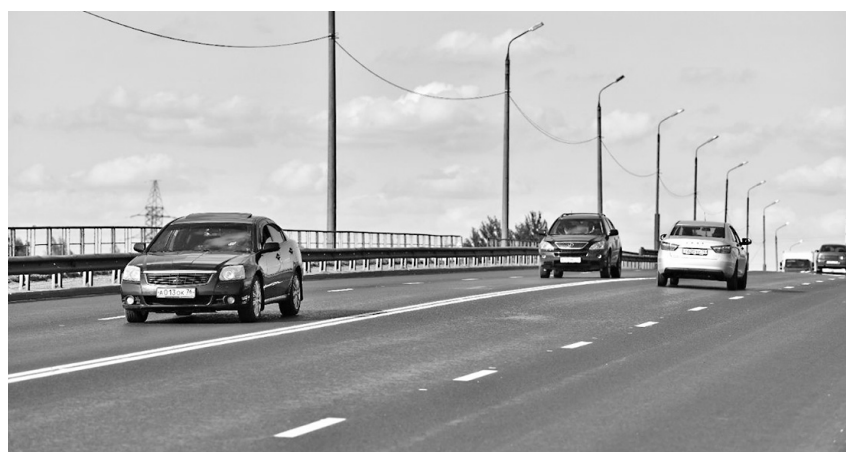
↓ Суринский путепровод отремонтирован за счет дополнительного финансирования из областного бюджета.
