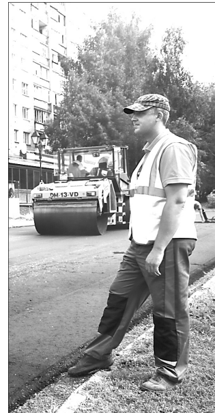
Укладка верхнего слоя асфальта ЩМА-20.
