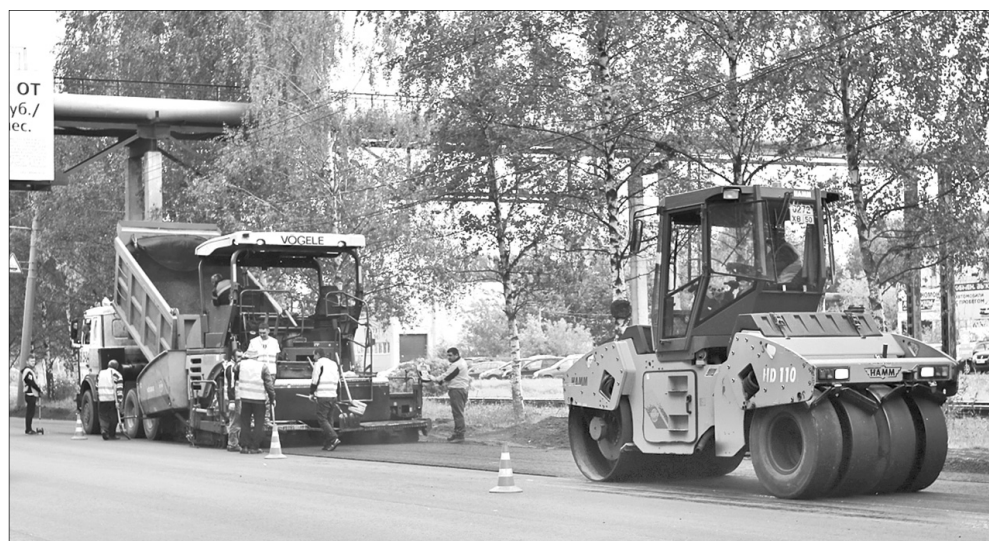
Ремонт Ленинградского проспекта.
