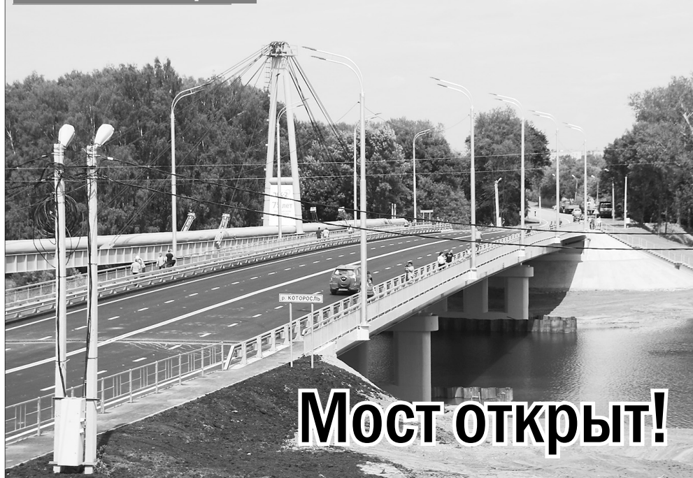
Движение по новому мосту началось 30 июня.
