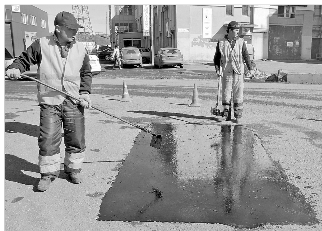
В первую очередь ремонтируют аварийные участки.
