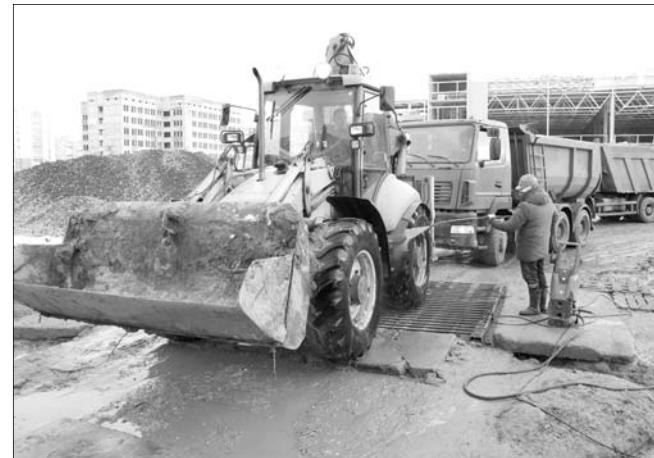
На выезде со стройплощадки – пункт мойки колес.
