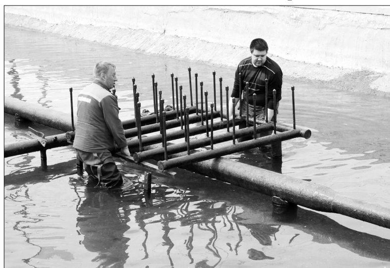
Идет демонтаж форсунок старого фонтана.
