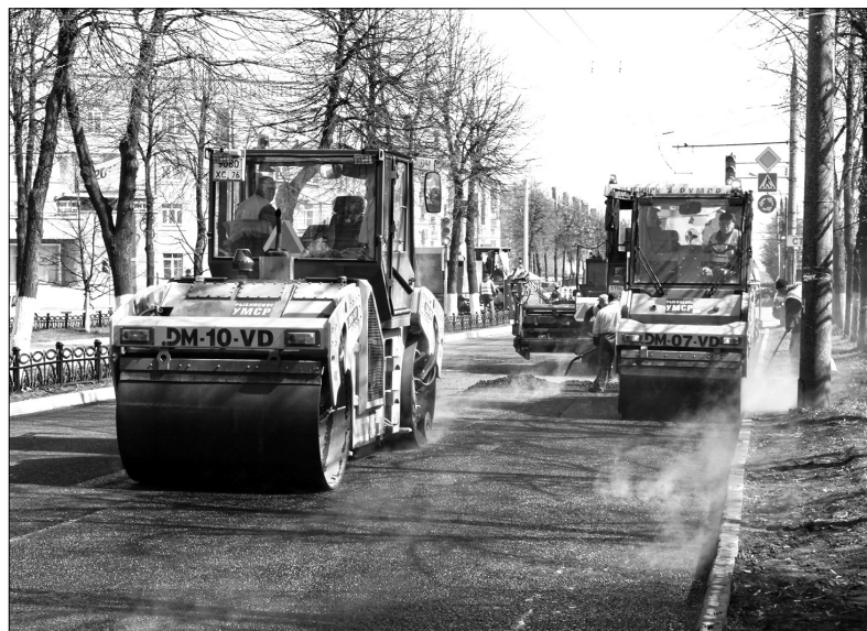
Укладка первого слоя асфальта велась щебеночно-мастичным асфальтобетоном.
