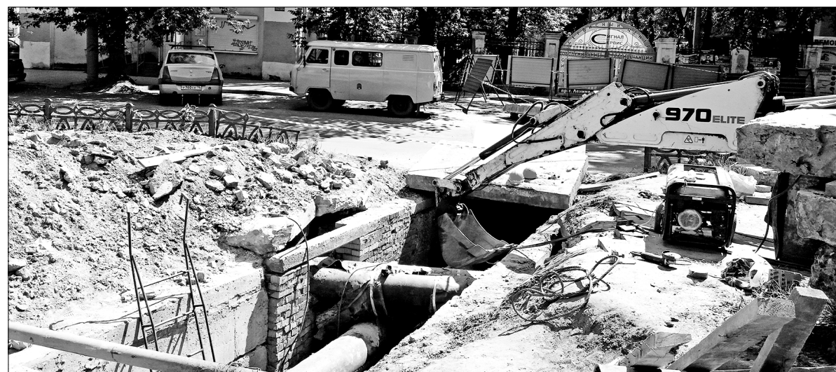
Замена коммуникаций на проспекте Ленина.
