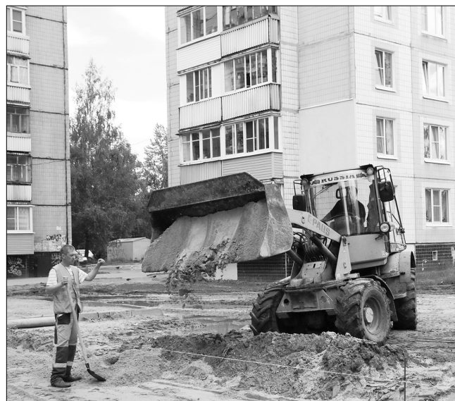
Работы во Фрунзенском районе идут полным ходом.
