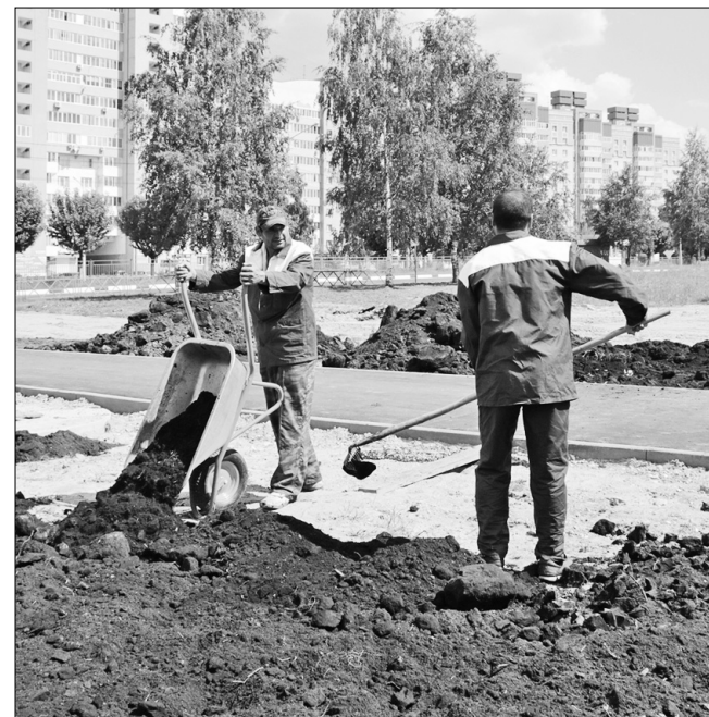
Ремонт улицы Колмогорова близится к завершению.
