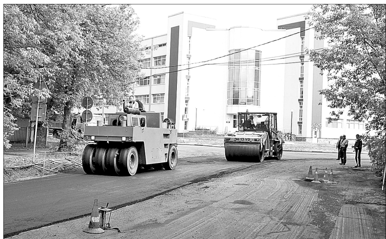
Укладка выравнивающего слоя асфальта на улице Чехова.
