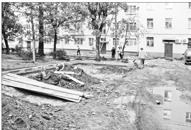
Работы кипят во всех районах города. Ремонт двора на Терешковой, 28.
