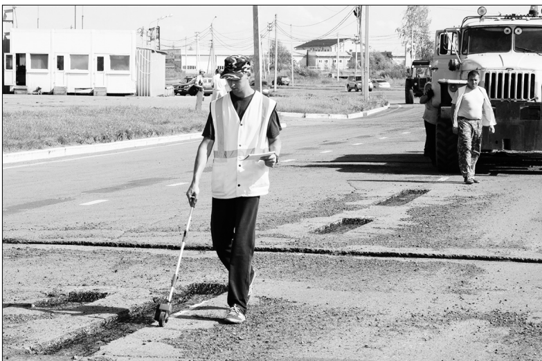
Ямочный ремонт Промышленного шоссе.
