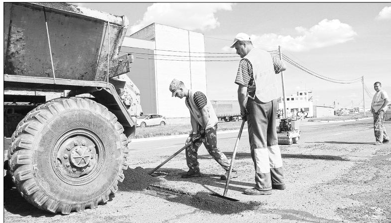
В Ярославле проведен ямочный ремонт на площади 150 тысяч квадратных метров.
