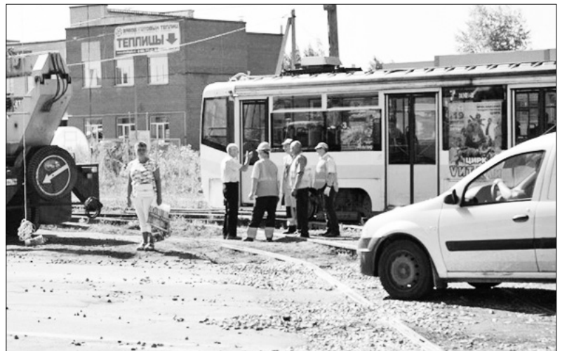
Первый этап работ на Ленинградском проспекте завершен.
