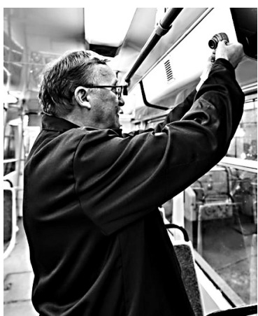
↓ Идет установка камер.
