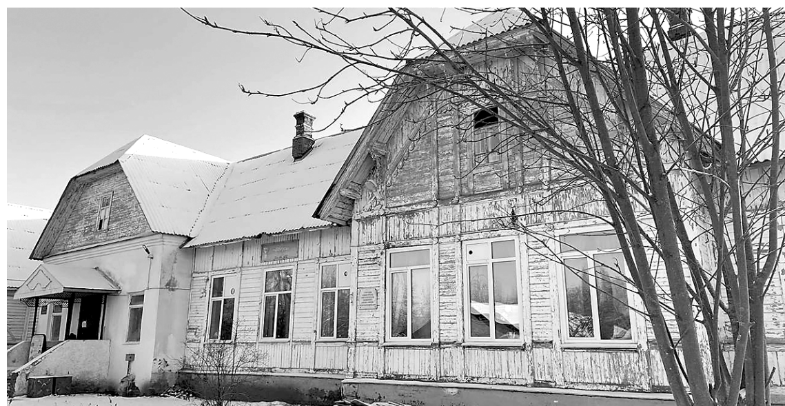
↓ Здание музея «История и быт Тверицкой слободы».
