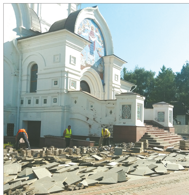
Замена плитки у Успенского собора.
