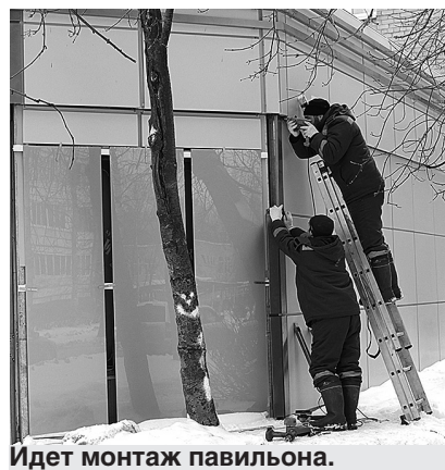
Идет монтаж павильона.
