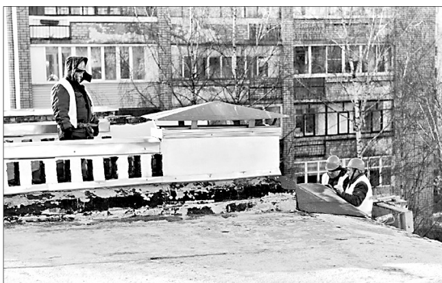
Идет ремонт металлических откосов кровли.
