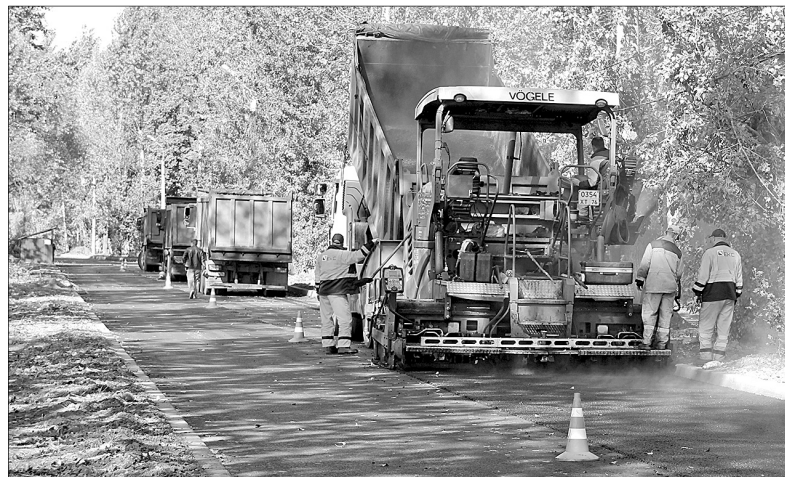
Протяженность ремонтируемого отрезка улицы Блюхера два километра.
