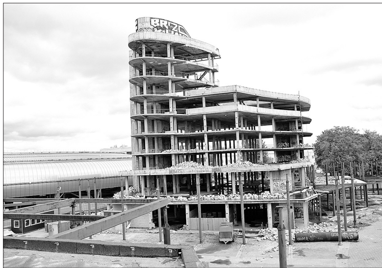
Работы на «Шиннике» возобновлены.
