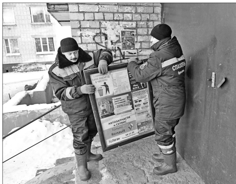
Демонтаж незаконной рекламы.
