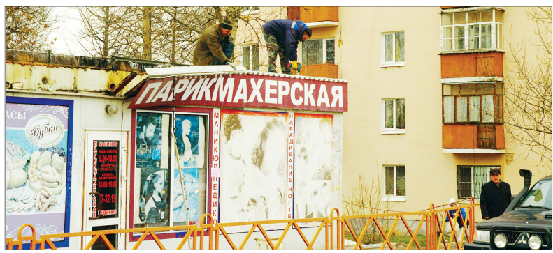
Демонтаж старого павильона.
