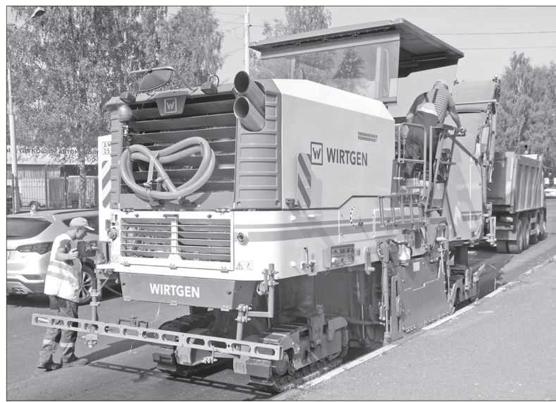
Улица Урочская. Ремонт идет от съезда с Октябрьского моста.
