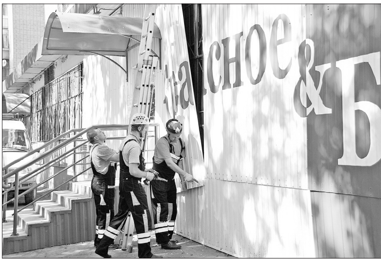
Демонтаж рекламы в Красноперекопском районе.
