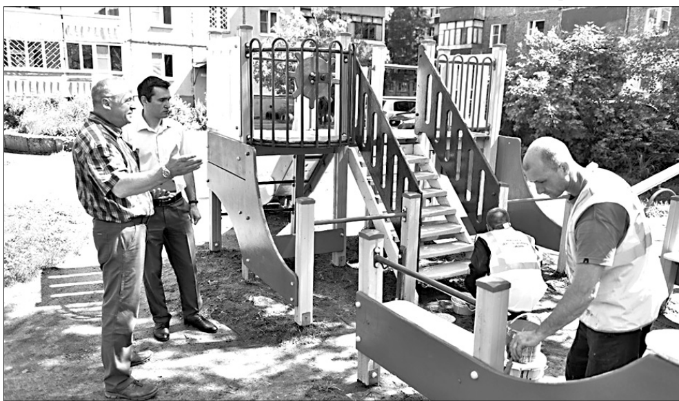
В процессе ремонта заменено практически 70 процентов элементов.
