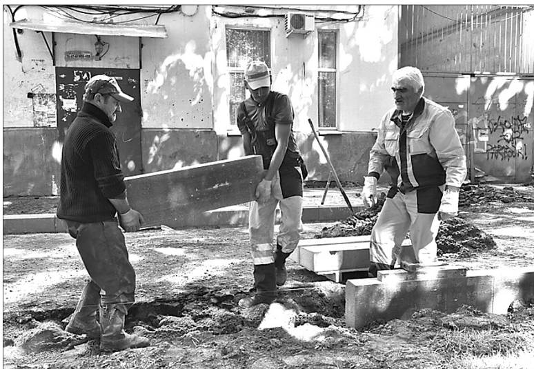
Демонтаж старого и установка нового бордюрного камня.
