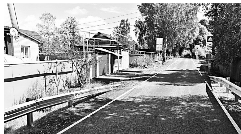
↓ После проведения работ ширина проезжей части уменьшится на 3,5 метра.
