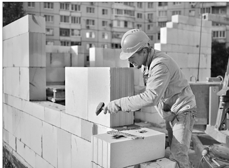
Ведутся работы по возведению первого этажа.
