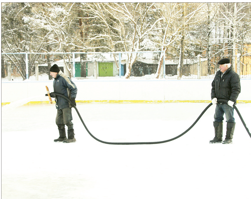
Одно из условий для заливки открытого катка — наличие 10-сантиметровой подушки из снега.
