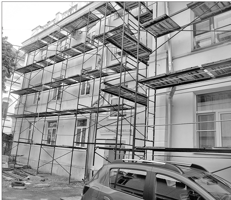
Работы по ремонту фасада идут на пересечении улицы Революционной и площади Челюскинцев.
