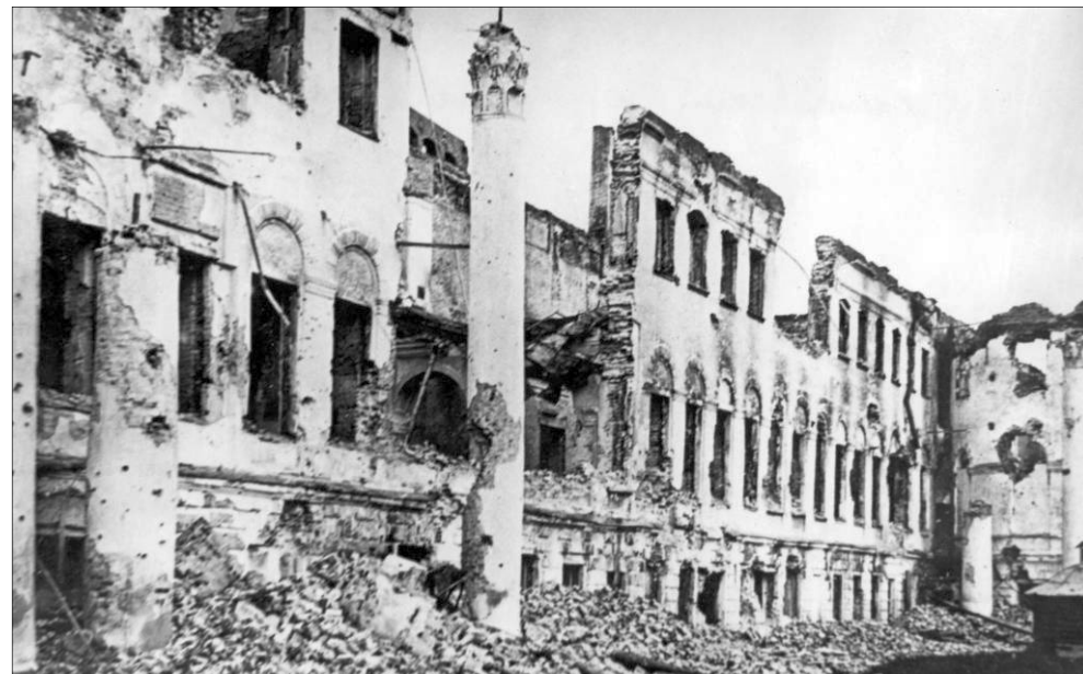
Многие здания после мятежа восстановить не удалось.
