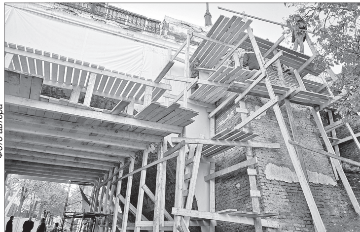
Строительство объекта «Мост — виадук через Медведицкий овраг с Подволжскими воротами» велось с 1820 по 1825 год. Реконструирован в 1957 году.
