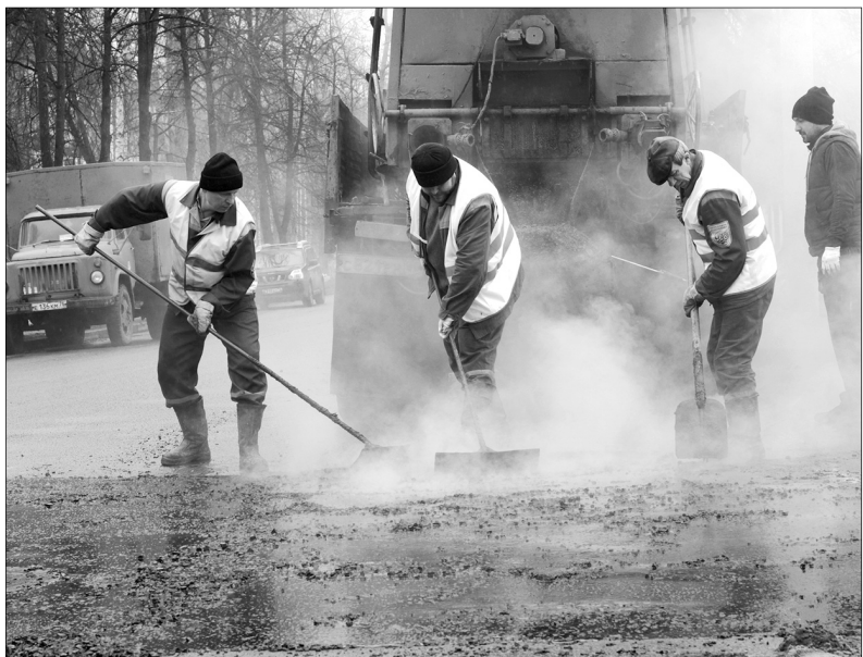
Восстановление дорожного полотна на улице Володарского.
