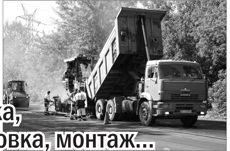
На Республиканском проезде укладывают верхний слой асфальта.
