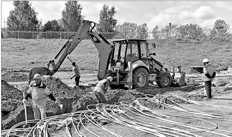
Идет 2-й этап реконструкции.
