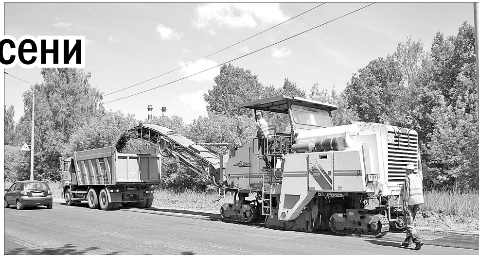
Фрезеруют асфальт в Заволжском районе.
