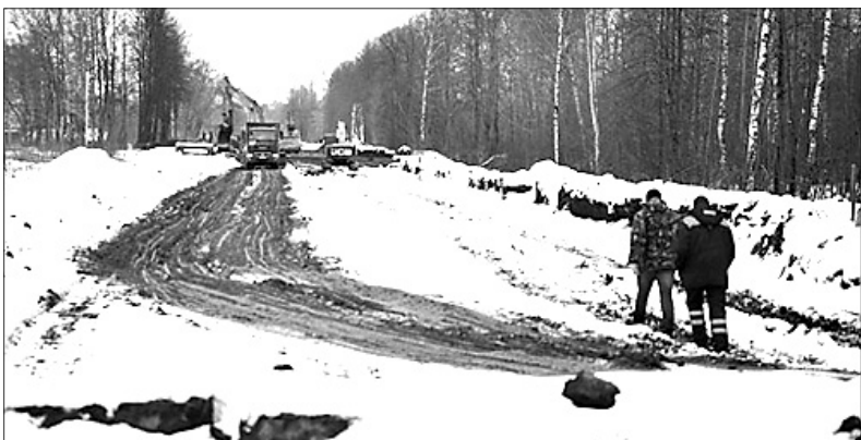
Срок окончания работ на Тутаевском шоссе – октябрь 2020 года.
