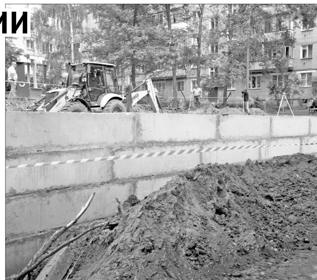
На проезде Ушакова идут масштабные работы.
