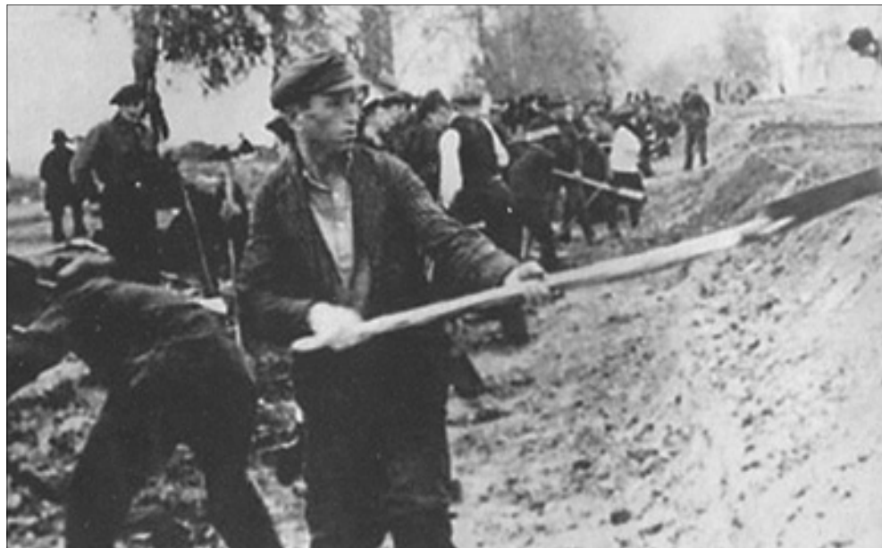
На строительстве оборонительных сооружений. 1941 г.
