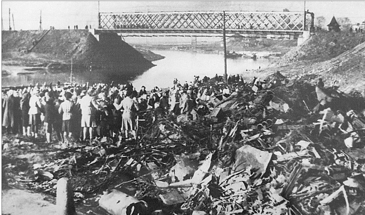
Общий вид набережной до начала работ.
