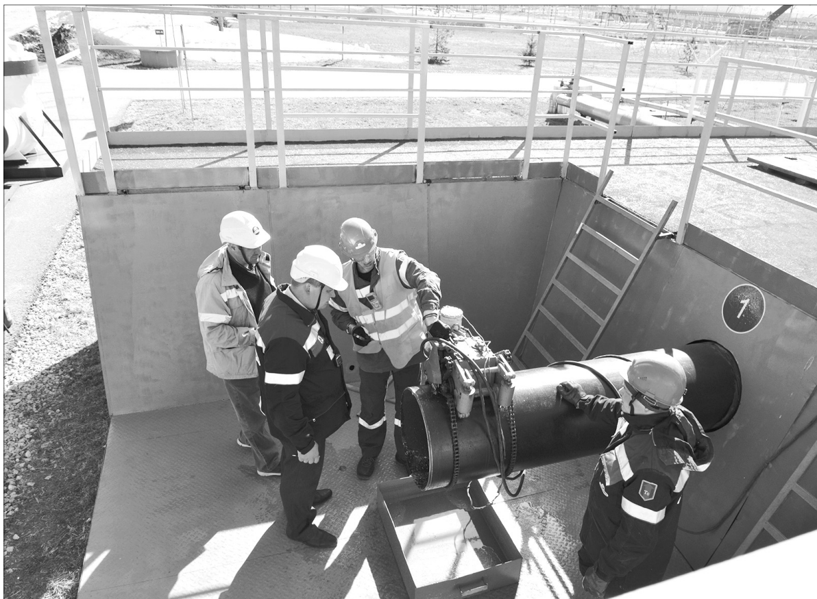
На этапе линейные трубопроводчики.
