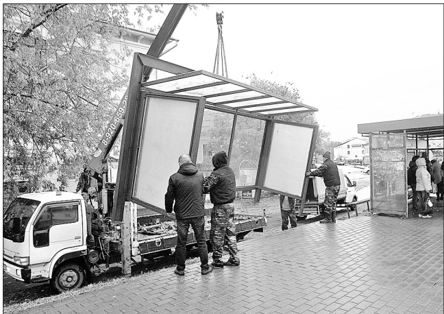
Идет установка остановочного комплекса.
