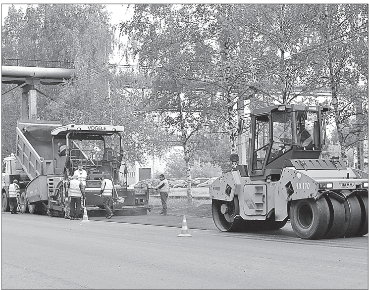
Идет укладка асфальта.
