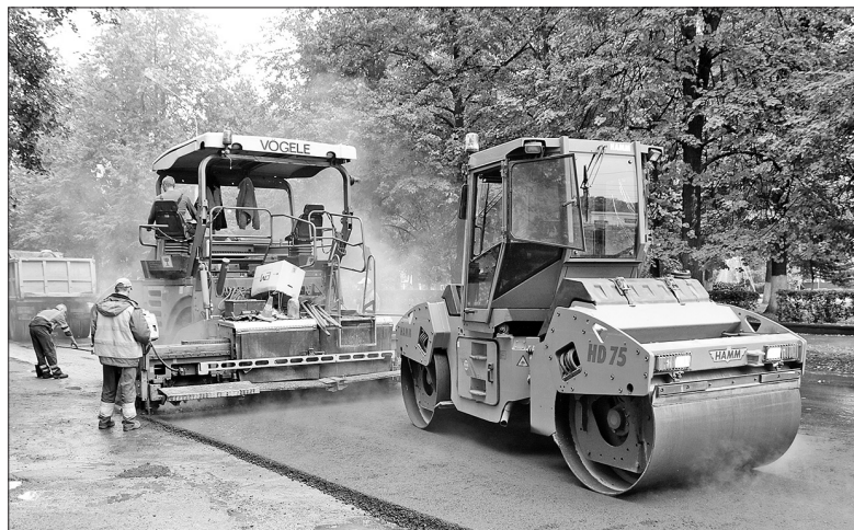
Ремонтные работы на улице Володарского.
