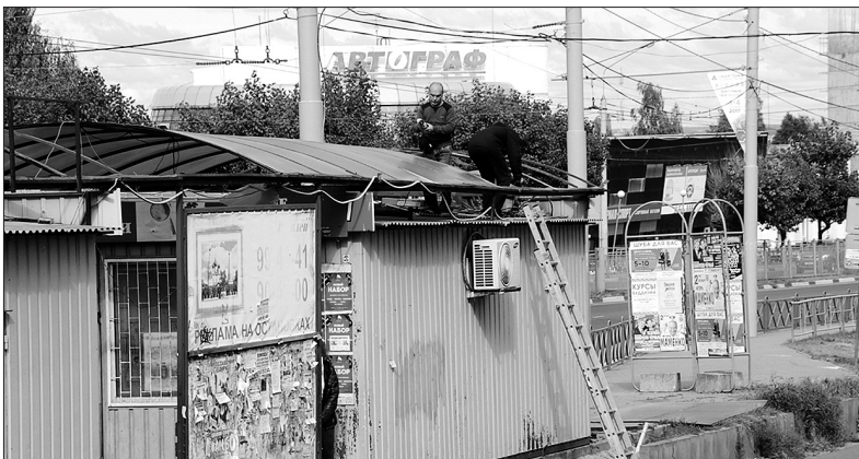
Старый павильон готовят к демонтажу.
